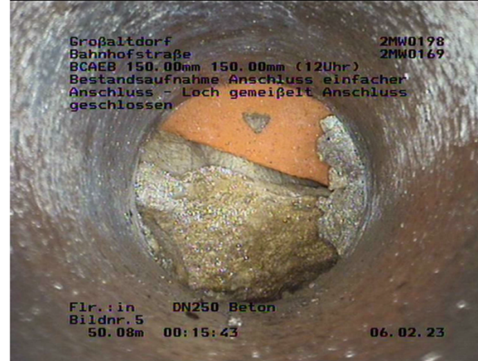
BCAEB : Anschluss einfacher Anschluss - Loch gemeißelt Anschluss geschlossen [12Uhr] 150,00 mm
