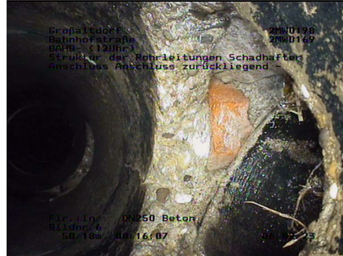
BAHB- : Schadhafte Anschluss Anschluss zurückliegend [12Uhr]
